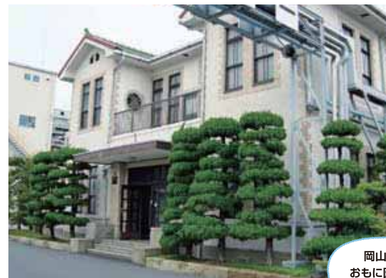
本館事務所(1915年建築)
