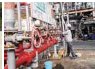
泡消火設備操法訓練
