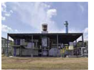
ガスタービン・コージェネレーションシステム 役割 | 自家発電、蒸気製造
