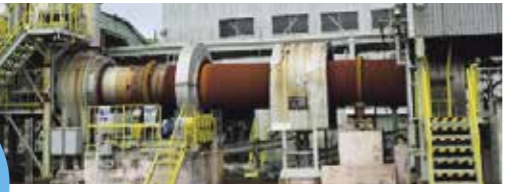
ロータリーキルン 焼却対象物 | 主に排水処理工程で発生した余剰汚泥※1 使用燃料 | 製造工程から発生する廃油を再利用
