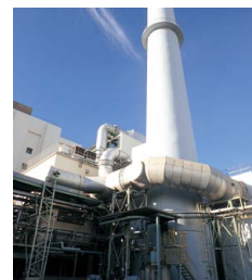
※3 ガスヒートポンプ
