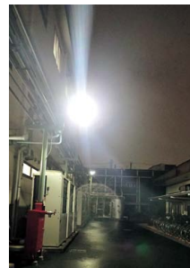
夜間自動点灯後、 人感センサー検知により 照度アップ
